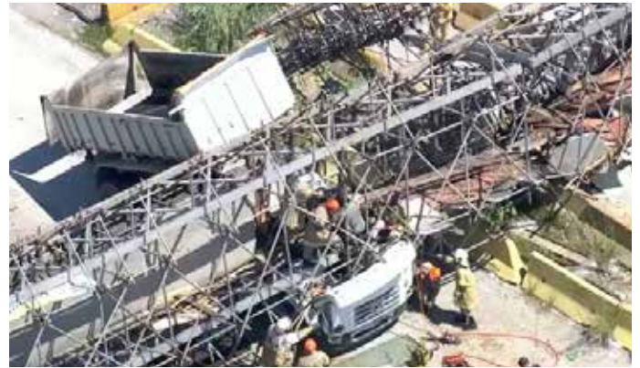
Figura 21 - Passarela na Avenida Brasil derrubada após colisão de caminhão.
