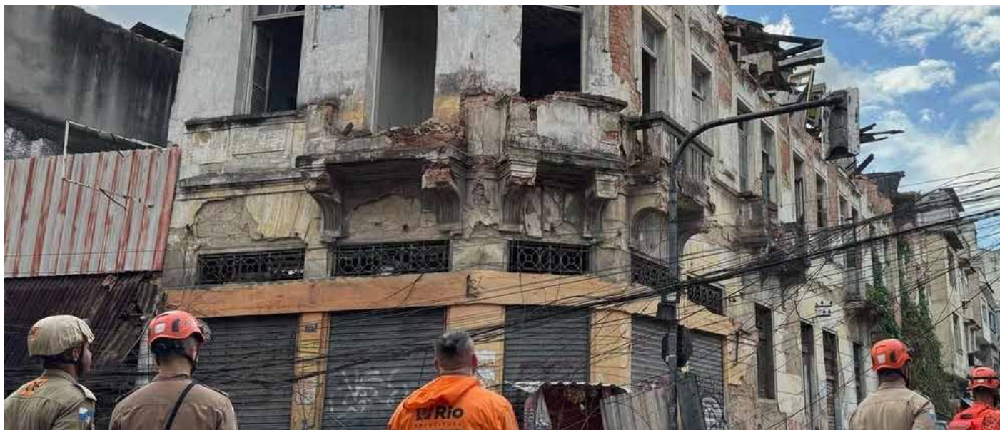
Figura 67 - Desabamento de casarão no Centro do Rio de Janeiro, com registro de um óbito.
