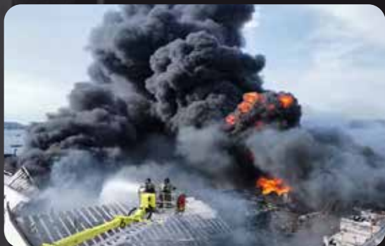
FIGURA 140. INCÊNDIO DE GRANDES PROPORÇÕES ATINGE FÁBRICA DE ÓLEO NA ILHA DO GOVERNADOR
