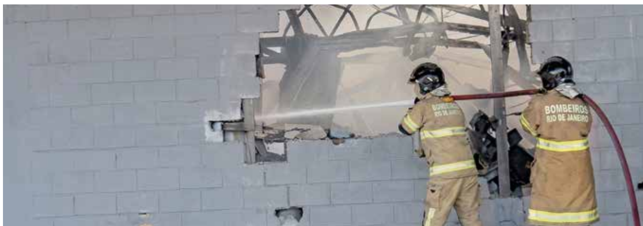
Figura 54 - Incêndio em galpão no aeroporto do Galeão.
