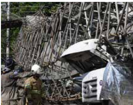
Figura 22 - Passarela na Avenida Brasil derrubada após colisão de caminhão.
