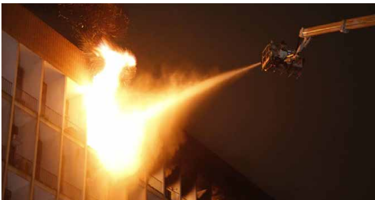
Figura 09 - Incêndio atinge prédio da reitoria da UFRJ no Fundão.
