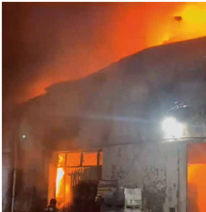
Figura 65 - Incêndio em galpão no Centro do Rio de Janeiro
