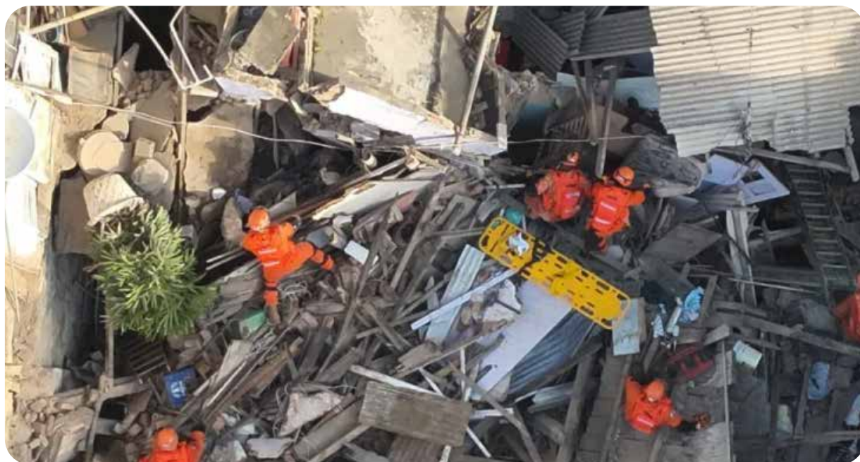
FIGURA 127. PARTE INTERNA DE SOBRADO DESABA NO CATETE E DEIXA FERIDOS.
