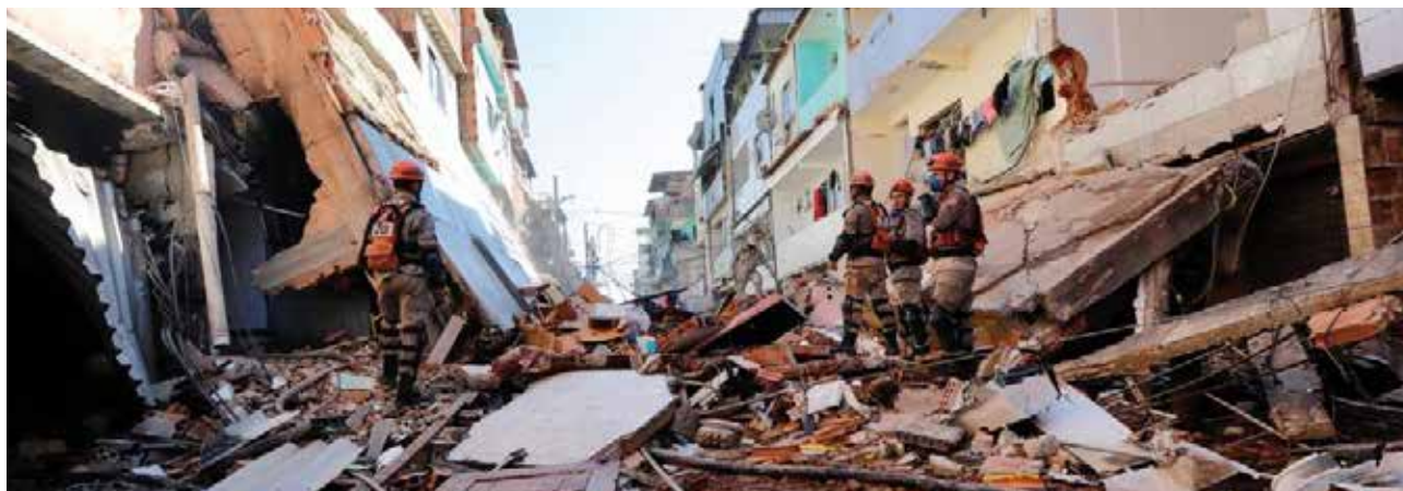
Figura 44 - Desabamento de prédio em Rio das Pedras.
