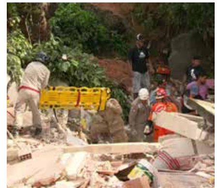
Figura 19 - Deslizamento no Morro da Boa Esperança.
