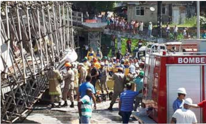
Figura 20 - Passarela na Avenida Brasil derrubada após colisão de caminhão.
