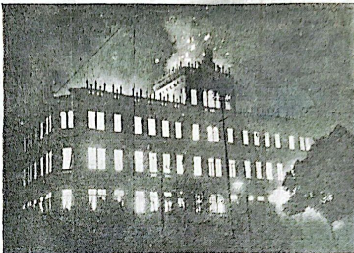
Aspecto do impressionante incêndio que destruiu totalmente o prédio da firma Dias Garcia
