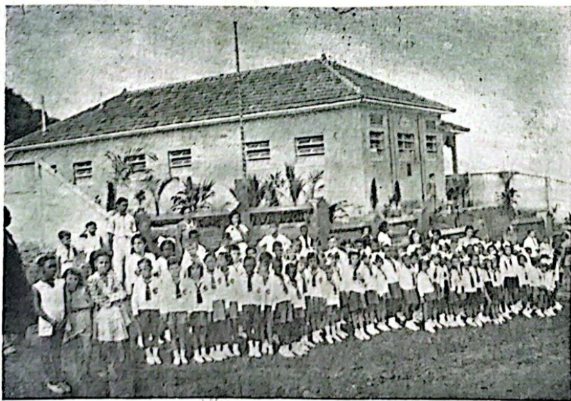
ESCOLA 2 DE JULHO, construída na administração do Cel. Aristarcho Pessoa para instrução primária das crianças pobres do Morro do Coruja, em São Cristóvão, à cargo da Cruzada Nacional de Educação
